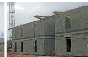
Partie nord (opération en cours d'achèvement)
