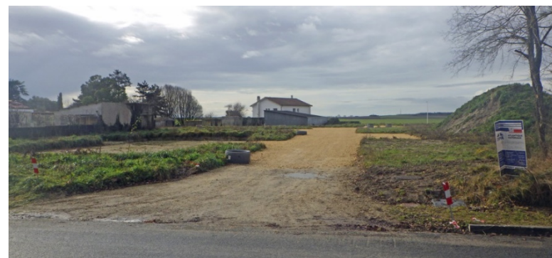
Aménagement en cours du secteur
