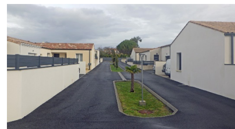
Partie 1 (côté ouest)
