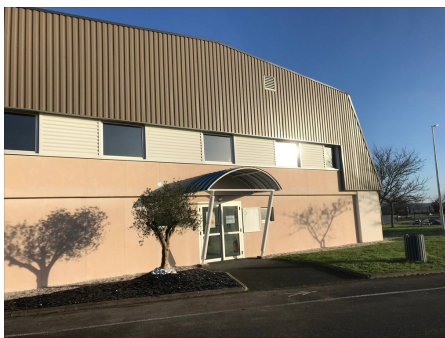
Gymnase – 22, rue des Morlons
